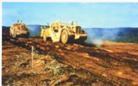
Газрын дээд хэсгийг хуулж буй байдал
